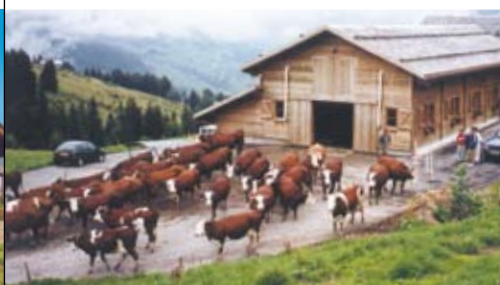
Bâtiment de stabulation en montagne
