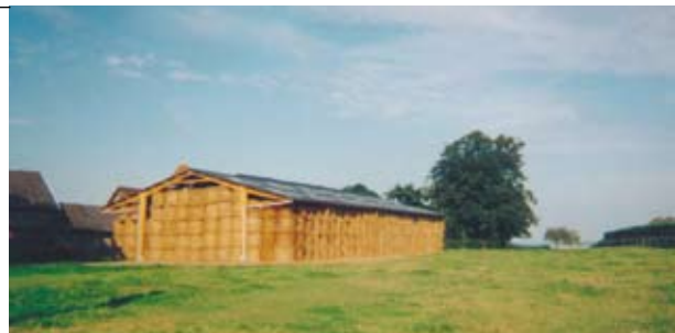
Bâtiment de stockage
