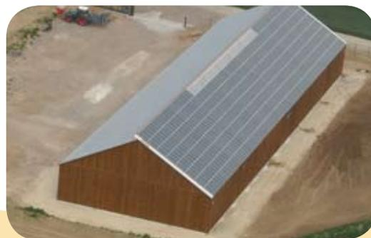
La production d'énergie renouvelable est un nouveau défi, relevé par les éleveurs. Ici, des panneaux photovoltaïques intégrés en toiture.
