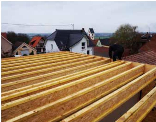
◀ Pour ce projet de maison individuelle de 160 m<sup>2</sup> sur 2 étages dans le Bas-Rhin, le mode constructif s'est basé sur un système ossature bois avec des poutres en I pour les murs, les planchers et la toiture. Cette solution technique a permis un gain de temps sur le chantier et un gain de surface en intégrant l'isolant insufflé entre les montants pour atteindre les performances d'un bâtiment passif.
