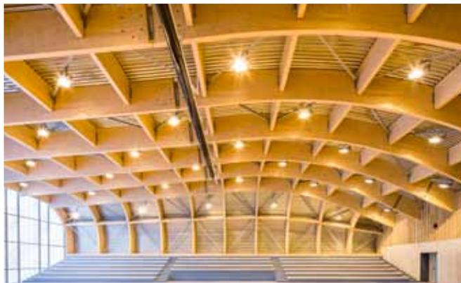
Le complexe sportif *Trivaux Garenne* à Clamart (92) imaginé par l'agence Gaëtan Le Penhuel Architectes est un bâtiment tout en courbes d'une grande complexité thermique et esthétique. Le recours au lamibois pour la réalisation de la charpente a permis d'effectuer de grandes poutres caissons courbes.
