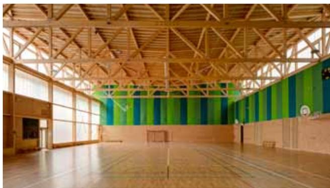
◀ La salle multisport du gymnase du Clos Jouvin (38) de 1 200 m<sup>2</sup> a été imaginée par l'agence r2k Architecte. La toiture est supportée par des poutres treillis d'entraxe 5 m volontairement laissées apparentes, ce qui a permis l'intégration de panneaux translucides en polycarbonate afin d'apporter une lumière diffuse à l'intérieur de l'édifice.
