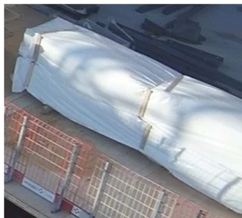
Figure 29 - Photo d'une protection de poutres et poteaux en bois lamellé collé stockés provisoirement en étage (Source MATHIS)
