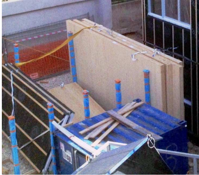
Figure 26 – Exemple de stockage vertical sur chantier de murs CLT (Source ARBONIS)
