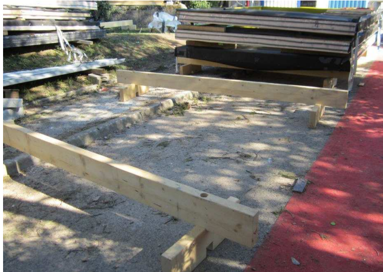
Figure 24 – Exemple de stockage sur chantier sur chevrons dans zone de stockage (source Arbonis)
