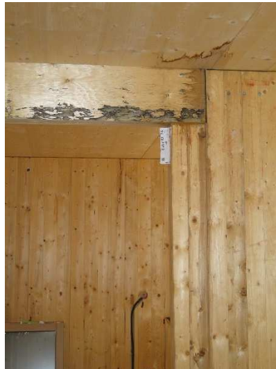
Figure 6 – Suite à des infiltrations d'eau, des traces d'efflorescences restent visible à la jonction plafond - linteau – poteau (Source AQC [34])
