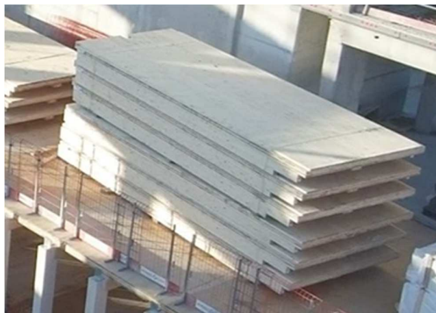
Figure 25 – Exemple de stockage provisoire d'éléments de planchers nervurés, stockés en étage sur cales (Source MATHIS)
