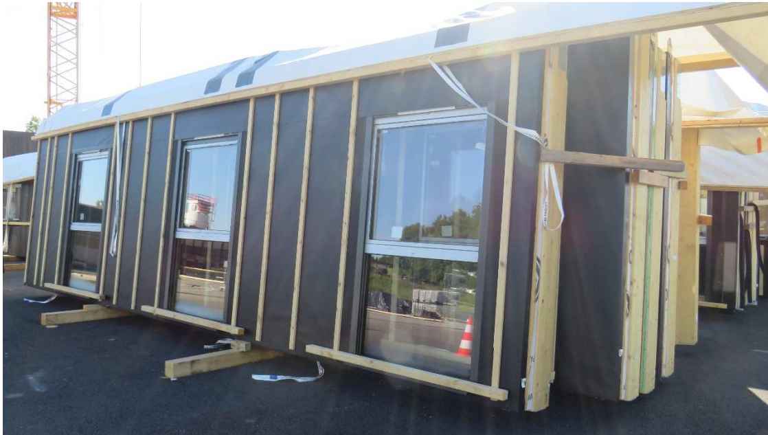
Figure 30 - Photo d'une protection de murs à ossature bois préfabriqués stockés verticalement (Source Arbonis)
