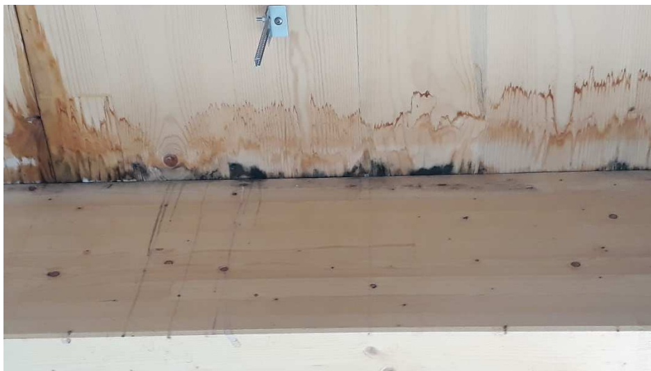
Figure 5 – Exemple de bleuïssement à la jonction plancher CLT/Poutre suite à une humidité excessive en phase chantier
