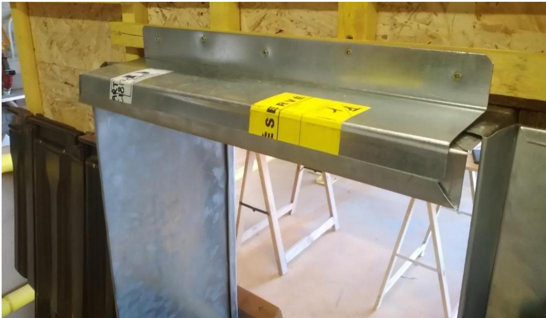
**Photographie 6 : Support de l'habillage de haut de baie : exemple de réalisation avec pièce de rigidité et de support en acier galvanisé sur petite ouverture**
