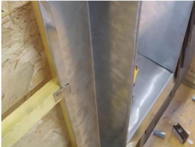
**Photographie 5 : Traitement des couloirs latéraux avec pattes de fixation. Les couloirs latéraux sont raccordés avec la bavette basse par recouvrement afin d'évacuer l'eau.**
