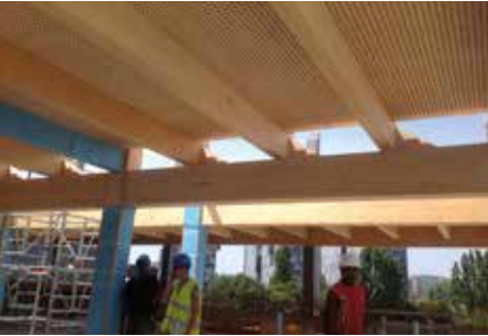
© Leclercq et Associés – ICM Structure (AIA Ingénierie)
