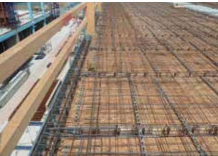
© Leclercq et Associés – ICM Structure (AIA Ingénierie)
